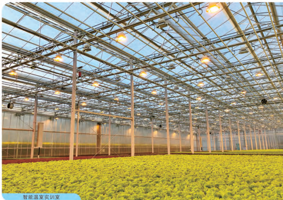
智能温室实训室
