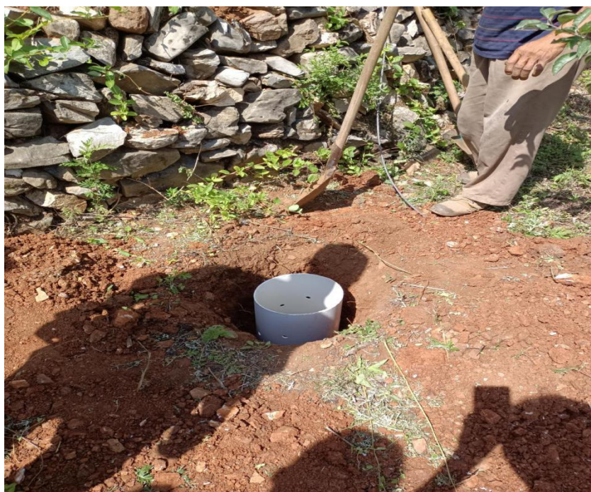
雨水收集装置埋设
