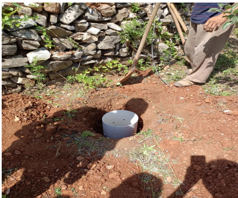
雨水收集装置埋设
